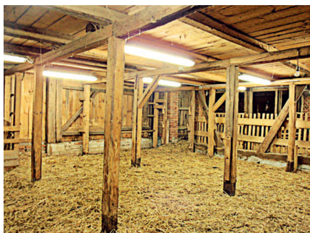
Slika 14. Prilagodba objekta i provedba svjetlosnog režima
